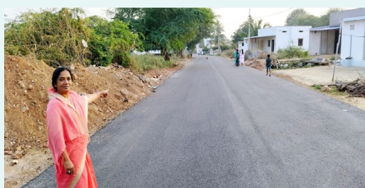
నాణ్యతను ఆమె పరిశీలించారు. అలాగే రామగిరి మండలం నసనకోట వంఠాయటి వెంకటాపురంలో 60లక్షలతో నిర్మిస్తున్న సీస రోడ్డును కూడా పరిశీలించారు. పనులు నాణ్యతలో రాజీ పడవద్దని
